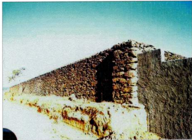
Vista da fachada posterior. Nota-se o encontro do muro de pedras com o muro de bloco de concreto chapiscado ( parte nova) (parte antiga) Foto: Marcela Borges, out de 2006
